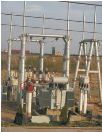
MCR型SVC无功补偿装置总体安装
