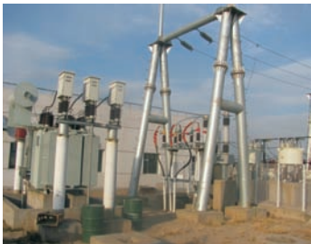
MCR型SVC无功补偿装置总体安装
