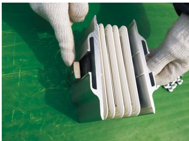
3 将活动接头螺栓完全选松，方螺母与螺杆端头平齐。
