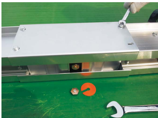
7 旋紧至上层螺栓头断开，红色标牌脱落，即标识螺栓已经旋紧。
