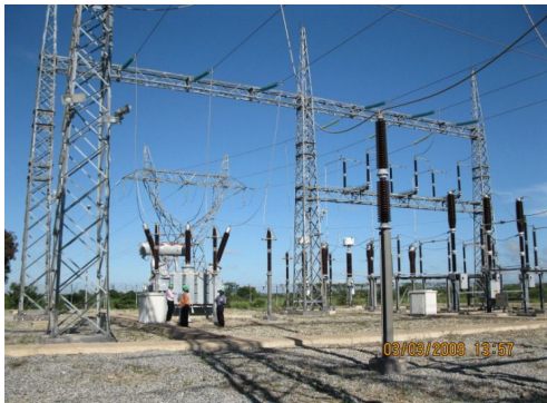
刚果（金）希图鲁铜矿220kV 变电站
