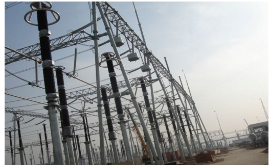
内蒙古包北变电站500kV 避雷器
