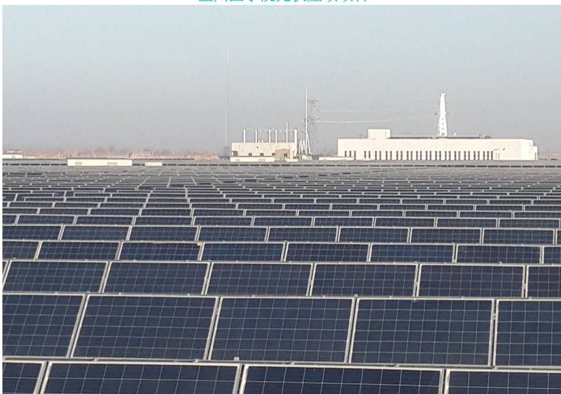
山西应县 60MW 太阳能发电项目
