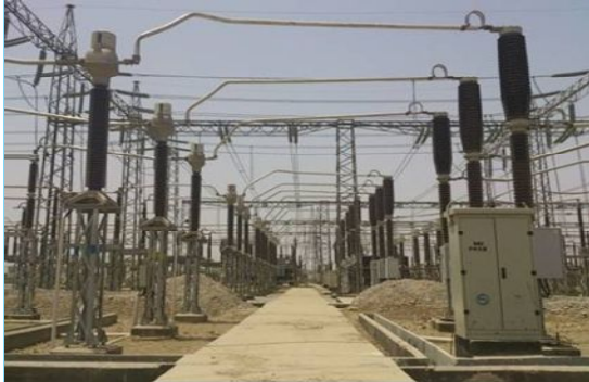
巴基斯坦国家电力局220kV Shikarpur变电站（总包工程）
