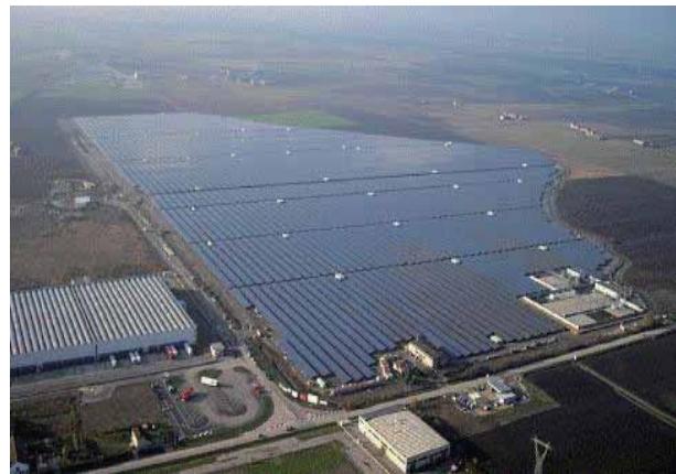
意大利Rovigo光伏电站70MW
