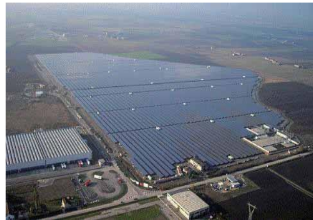
意大利Rovigo光伏电站70MW
